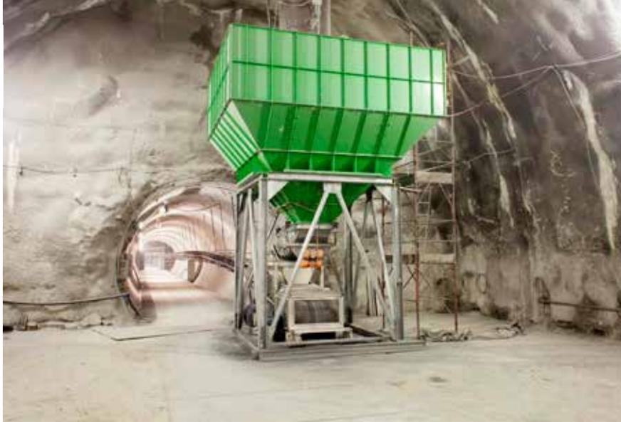
Das gesamte Ausbruchsmaterial wird im Erkundungsstollen mit einem Förderband abtransportiert.
